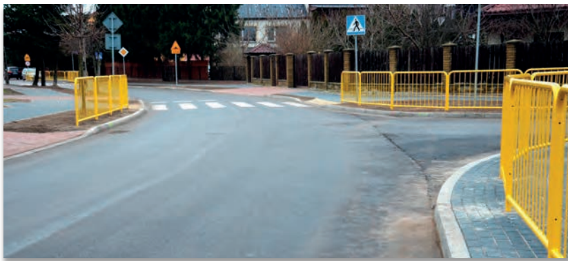
Wyremontowana ulica Prusa
