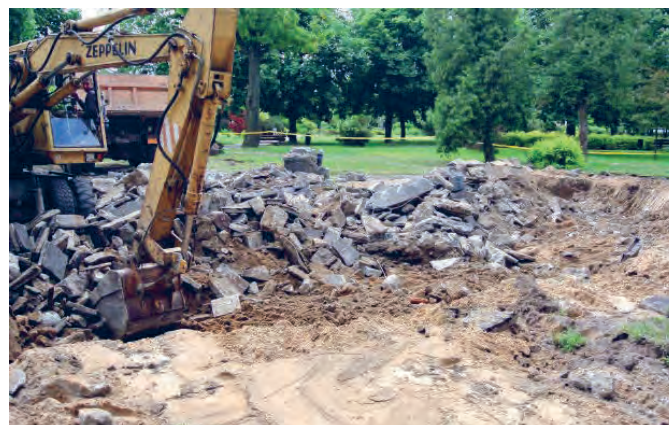
Podczas prac remontowych
