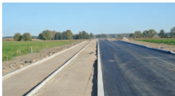
Na zdjęciach budowa „małej obwodnicy”
