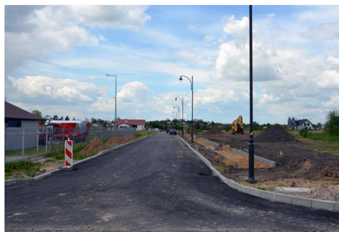
Trwająca budowa ulic na osiedlu przy ul. Warszawskiej
