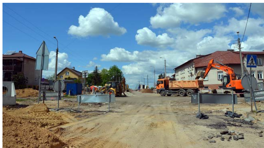
Na zdjęciach przebudowa ulicy 1 Maja
