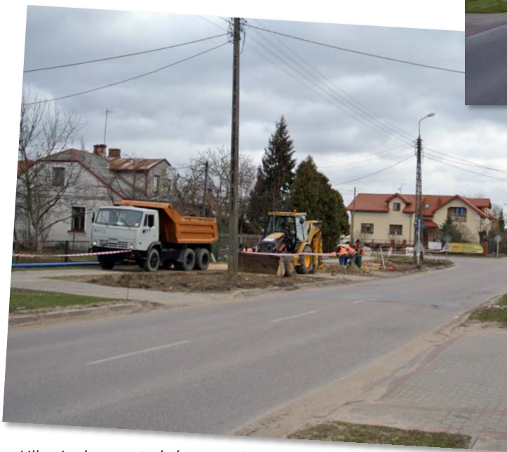
Ulica Ludowa w trakcie remontu
