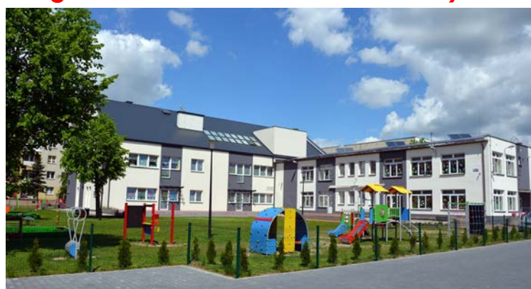
Przedszkole Miejskie nr 1 po remoncie
