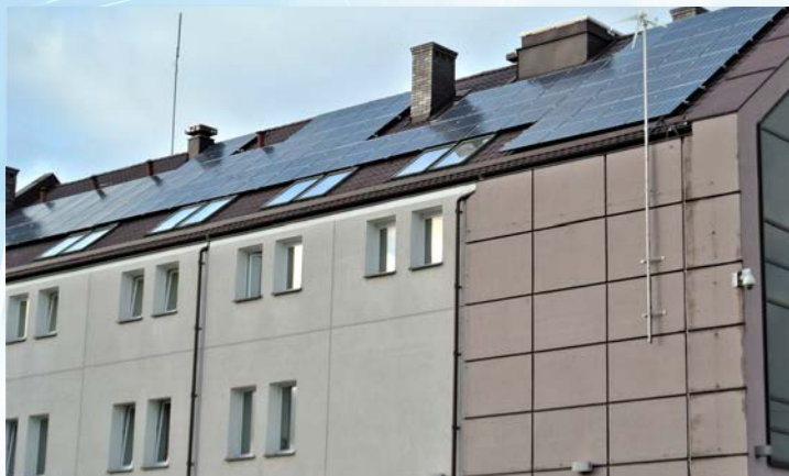
Instalacja OZE na budynku Urzędu Miasta
