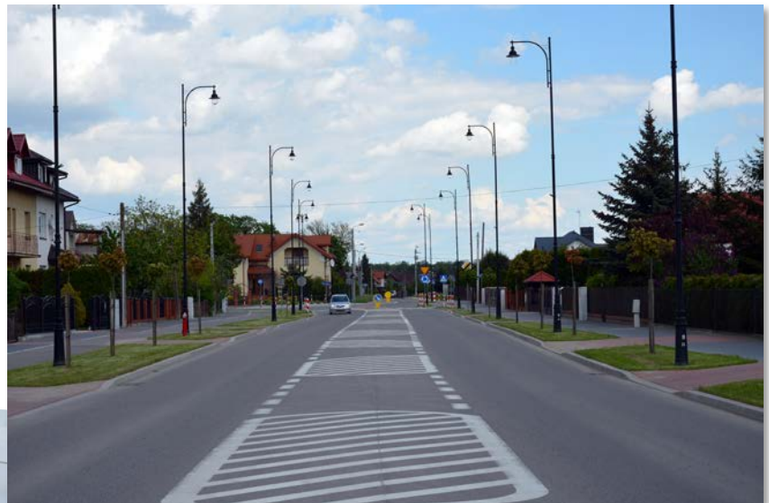
Ulica Ludowa po remoncie
