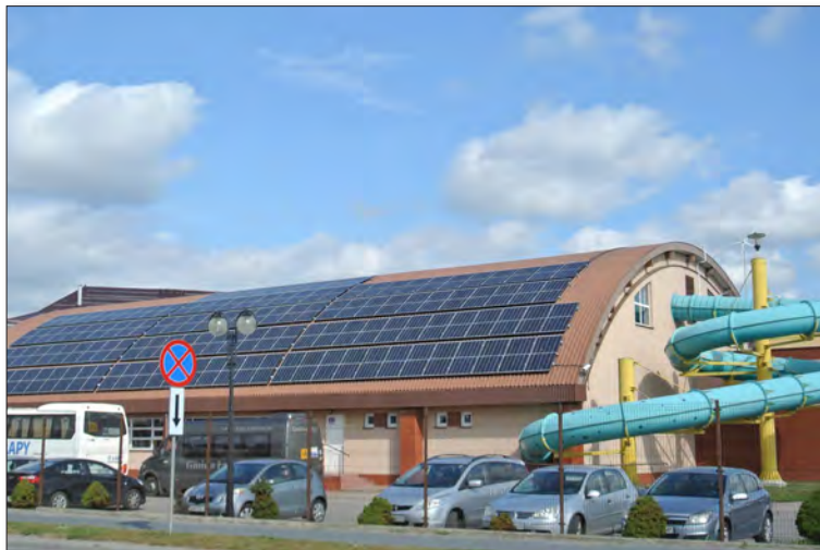
Panele fotowoltaiczne na budynku Miejskiej Pływalni „Wodnik”
