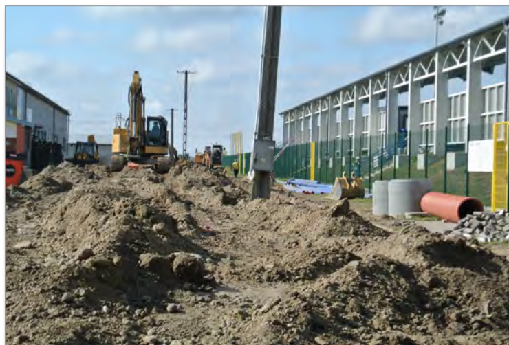
Budowa nowej ulicy przy stadionie
