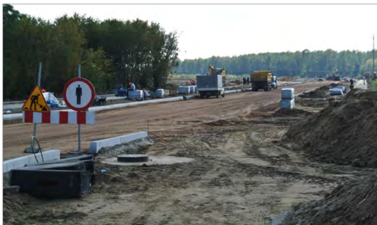
Budowa nowej drogi łączącej ul. 1 Maja z ul. Ludową
