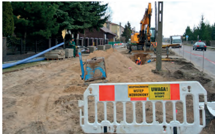
ul. Ludowa w trakcie remontu
