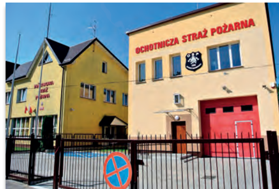
.... i po remoncie
