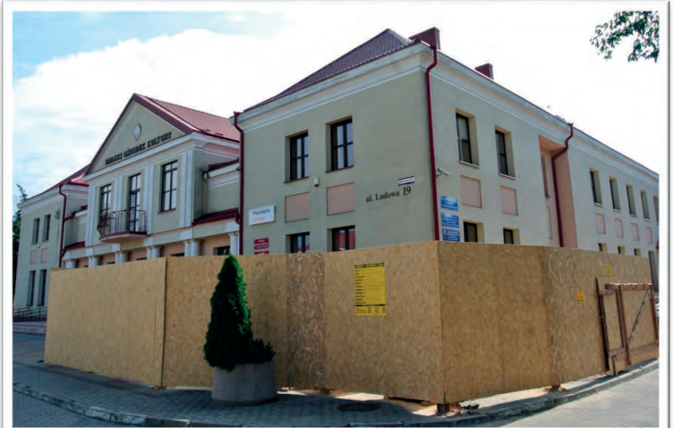
Miejski Ośrodek Kultury w trakcie remontu
