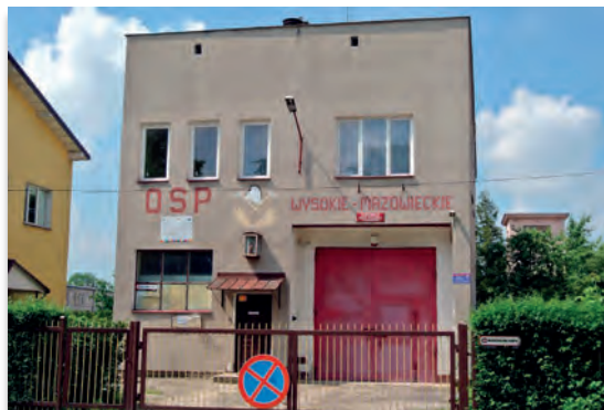
Budynek Ochotniczej Straży Pożarnej przed remontem....
