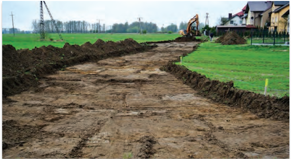
Droga, która połączy ul. 1 Maja z ul. Szpitalną
